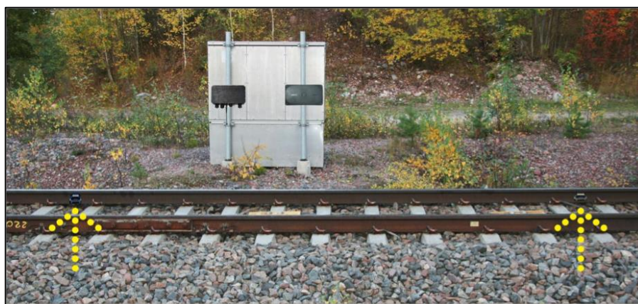
Rys. 3.13. Rozmieszczenie czytników RFID na torach kolejowych [18]
