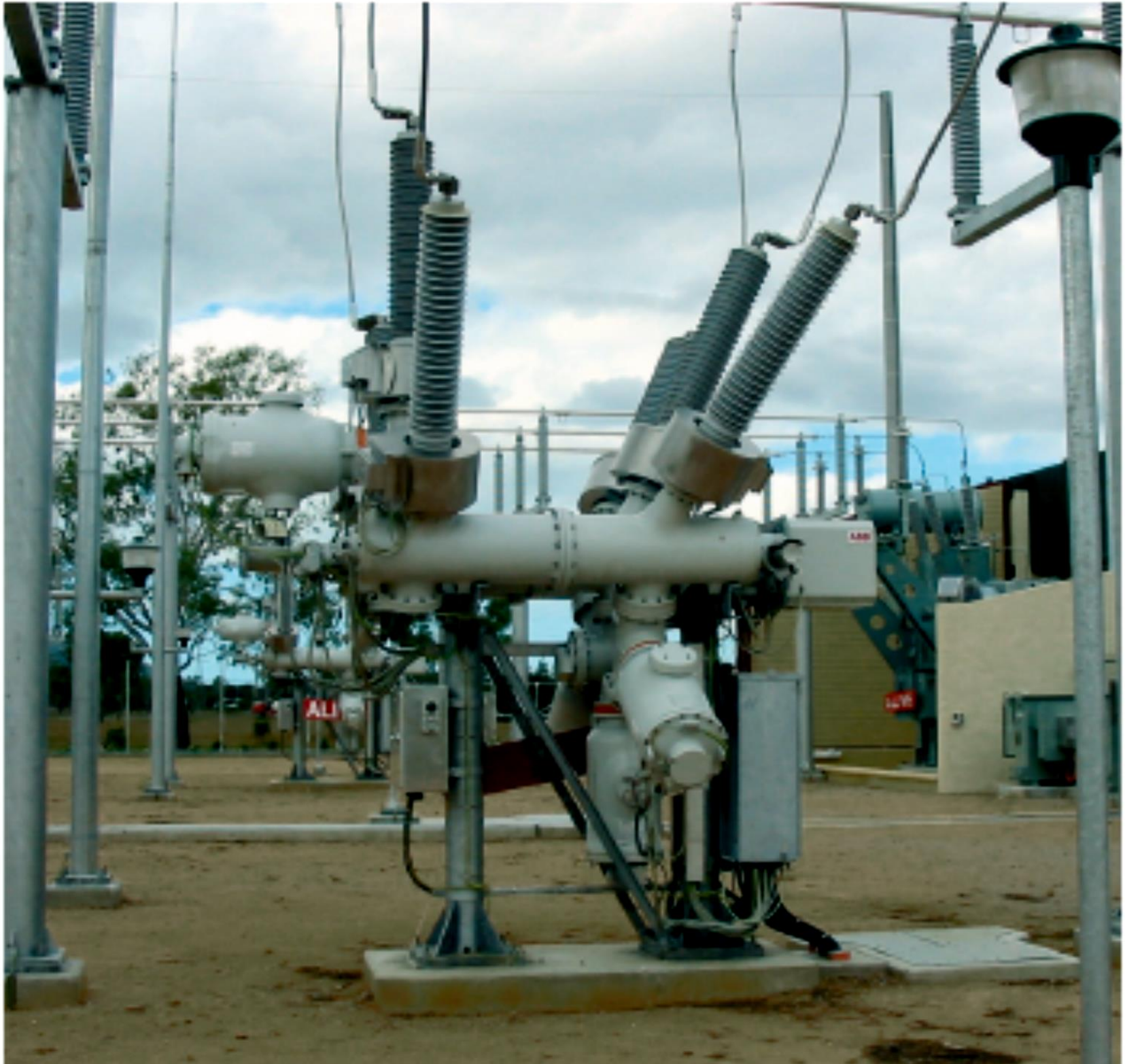
Moduł rozdzielnic PASS - pole liniowe.
