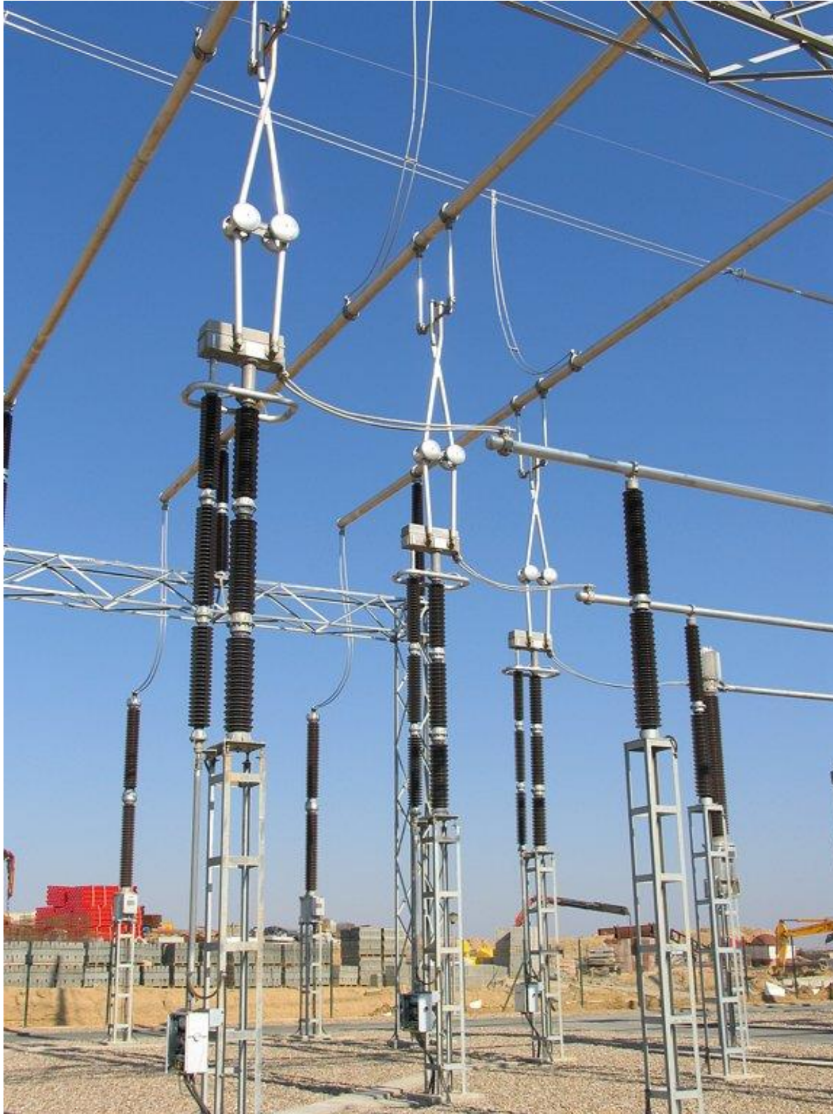
Przykład odłączników napowietrznych pantografowych (nożycowych) 400 kV.
