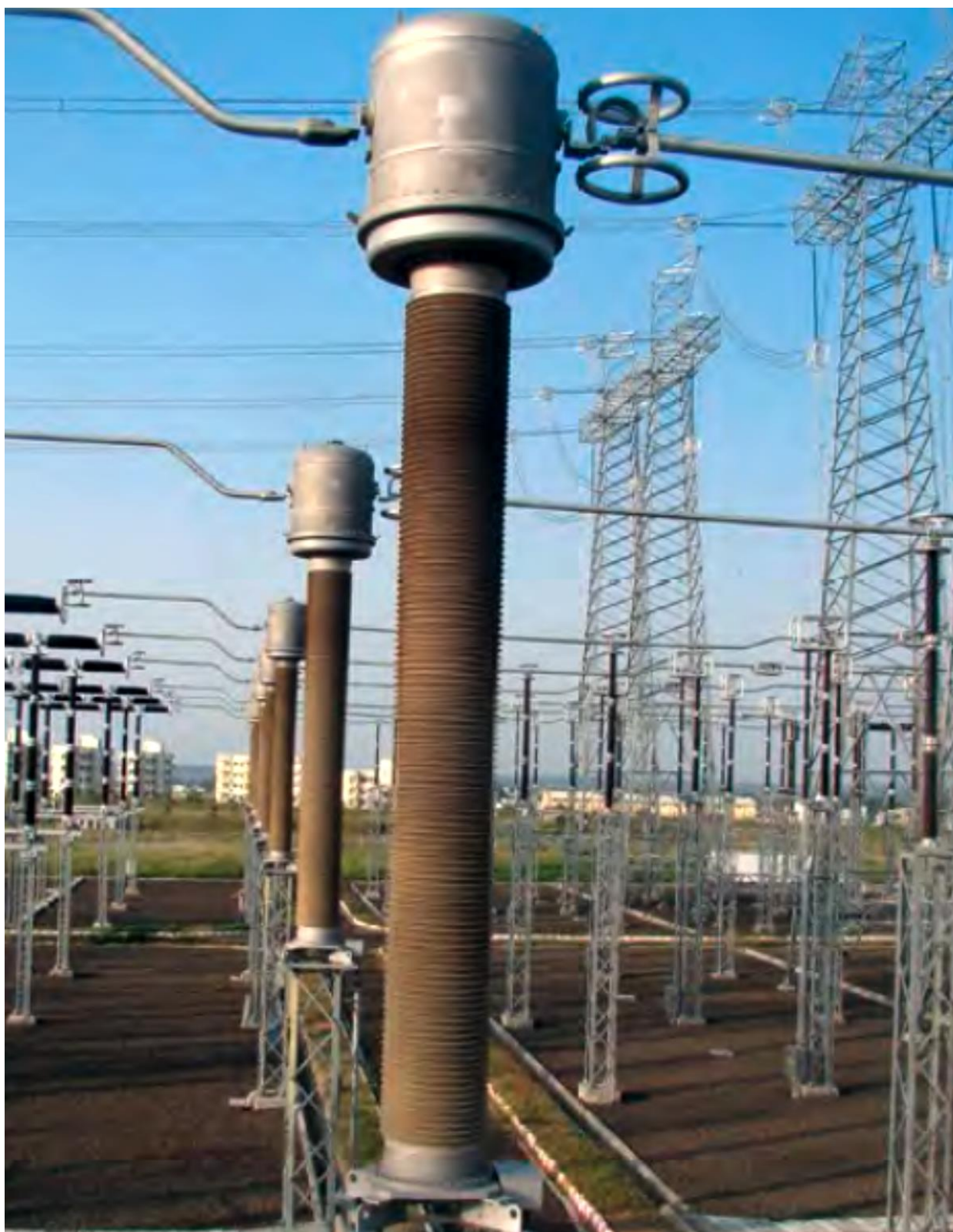
Przekładnik prądowy 800 kV izolowany SF 6
