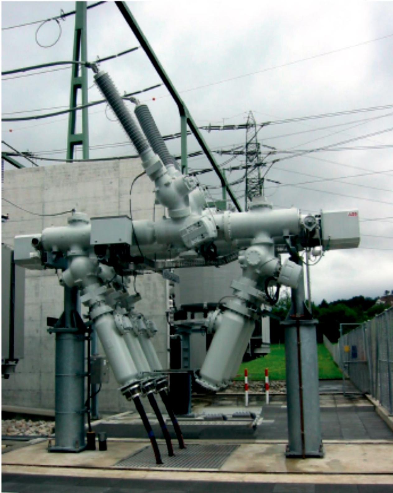
Moduł rozdzielnic WN izolowanej SF 6
