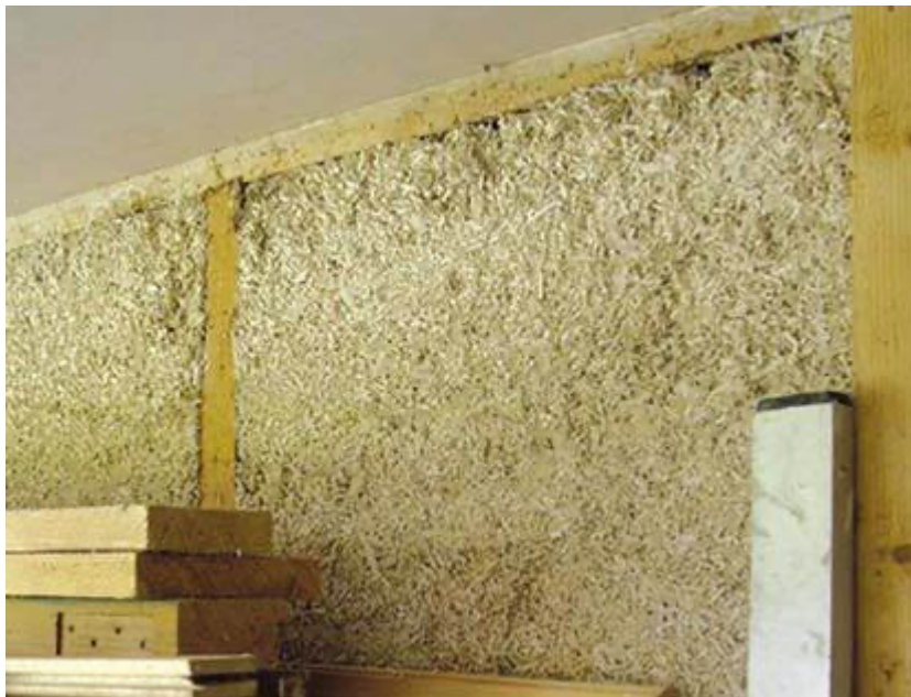
Rys. 7. Kompozyt wapienno-konopny jako wypełnienie ścian
